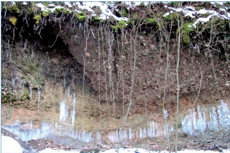
Bild 8. Wasseraustritt aus der Oberen Süsswassermolasse im Einzugsgebiet der Töss (ZH) im Grenzbereich zwischen einer Nagelfluh- (oben) und einer stauenden Mergelschicht (unten). Bei tiefen Temperaturen gefriert das langsam aus dem Festgestein austretende Wasser und wird so sichtbar.
